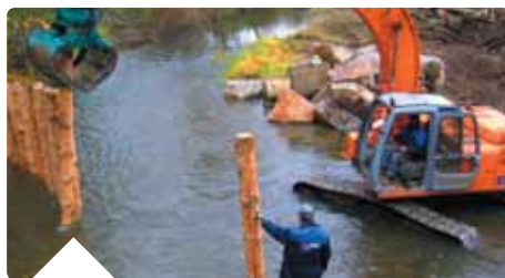
Usazování dřevěných pilot bagrem.
