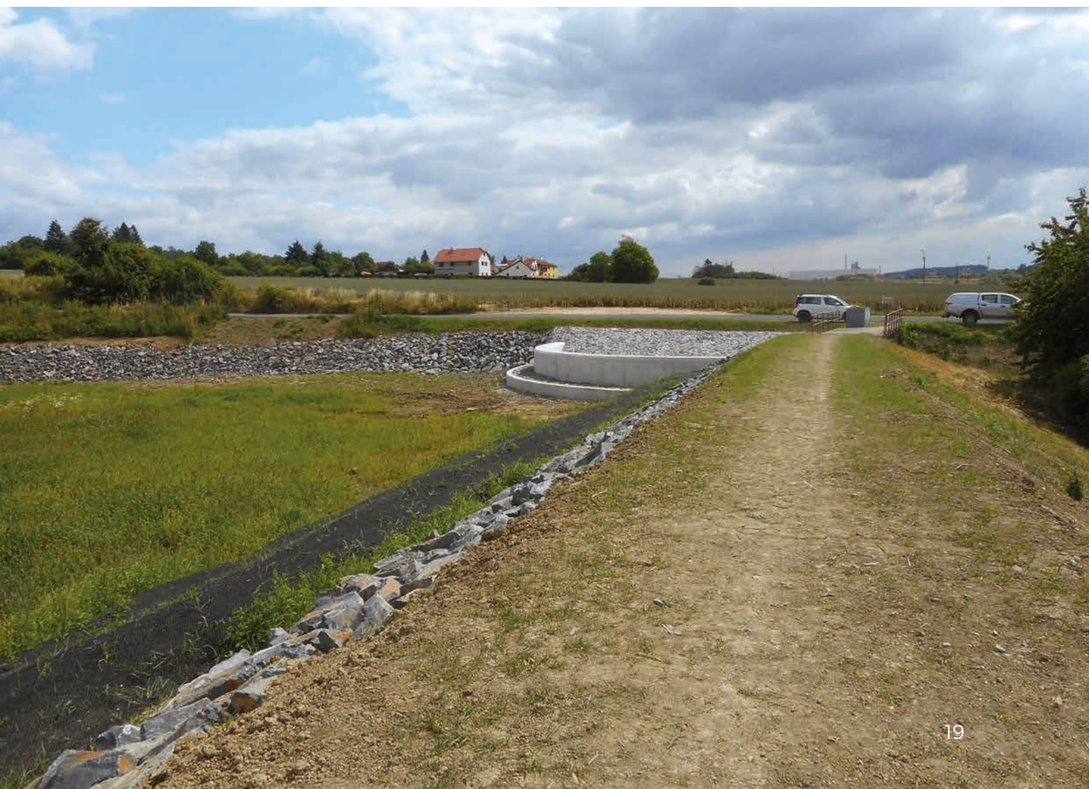
Nově provedená stabilizace břehů a hráze a opravený bezpečnostní přeliv, červenec 2019 ↓
