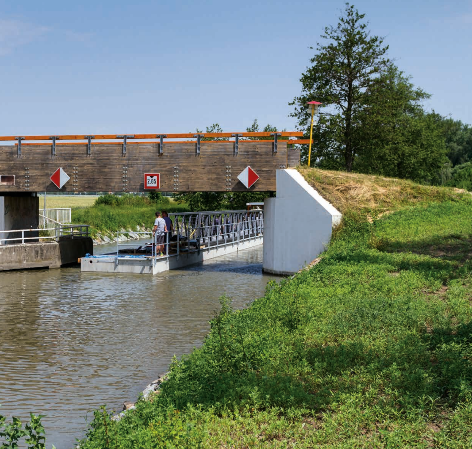
Úprava plavebního značení na mostech Baťova kanálu ↑
