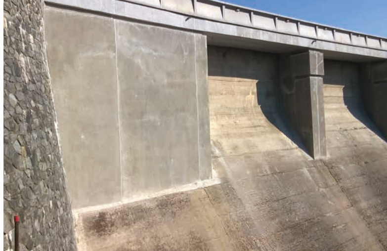
Po provedení sanace ↑
