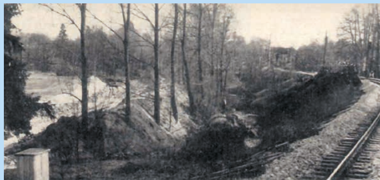
↑ Vlevo jde vidět nově vybudované koryto, do kterého byla řeka Jihlava převedena
