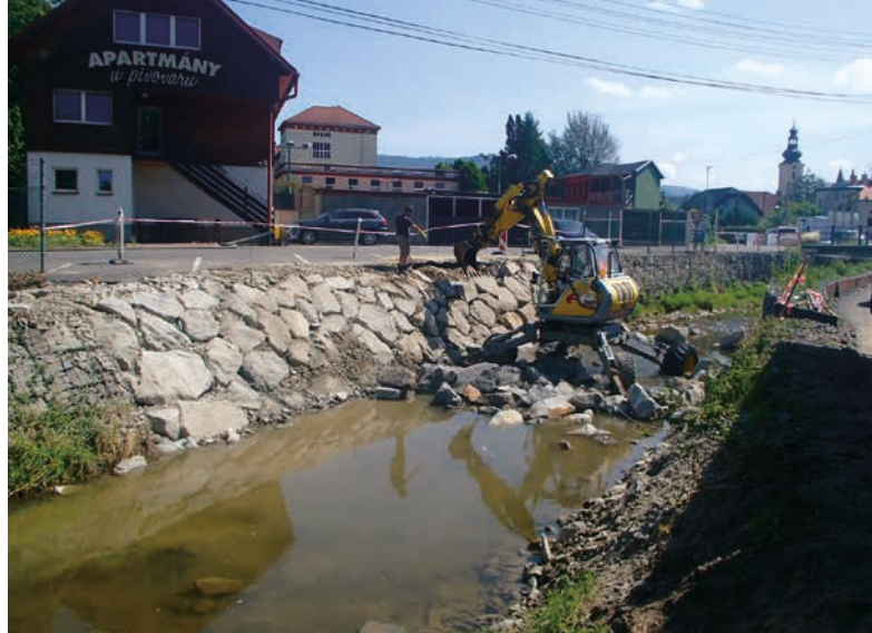
Zabezpečovací práce na Hážovickém potoce ↑
