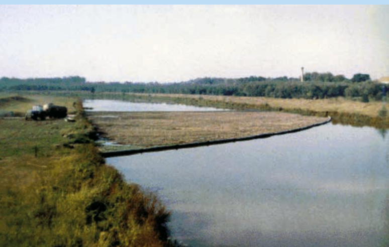
↑ Hromadný úhyn ryb o hmotnosti cca 250 t v Horní nádrži VDNM v lednu 1984 ↓ Norná stěna bránila postupu neživé organické hmoty z Dyje do Horní nádrže VDNM
