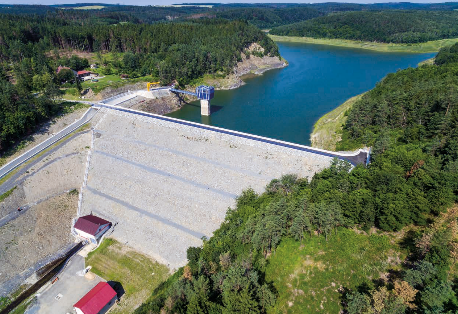
↑ VD Opatovice po rekonstrukci, červen 2019
