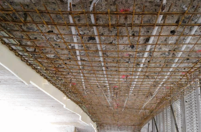
↑ Detail pilíře připraveného pro nástřik sanační hmoty
