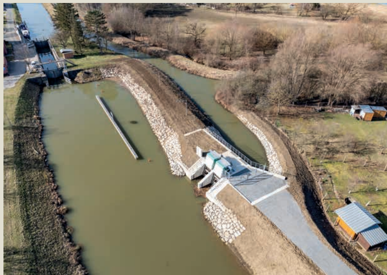
Nápustné stavidlo je umístěno v pravobřežní hrázi ↑ horní rejdry plavební komory Veselí nad Moravou
