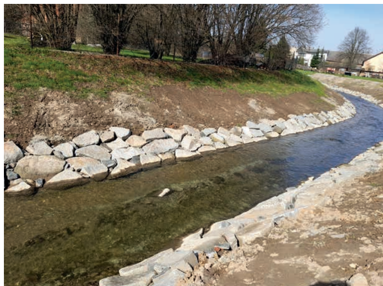
Dvoukilometrový úsek Kunčinského potoku má opravené opevnění a zkapacitněný průtočný profil ↑
