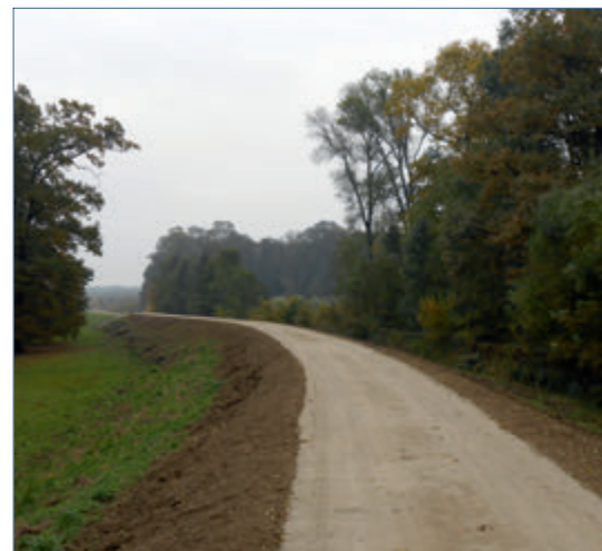
Levobřežní protipovodňová hráz řeky Dyje
