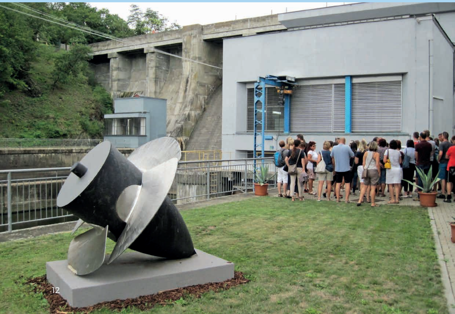
↓ Kaplanova turbína je osazena také v MVE na vodním díle Brno, k vidění je samotná turbína také před elektrárnou
