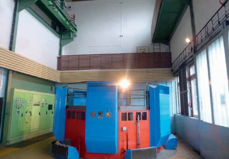
↑ Kaplanova turbína osazená v MVE Nové Mlýny
