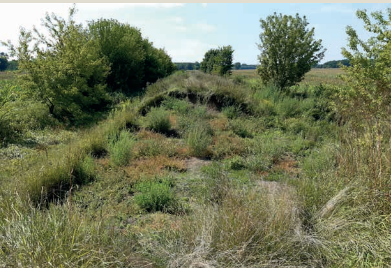
↑ Protržená pravobřežní hráz Moravy po povodni 2020...
