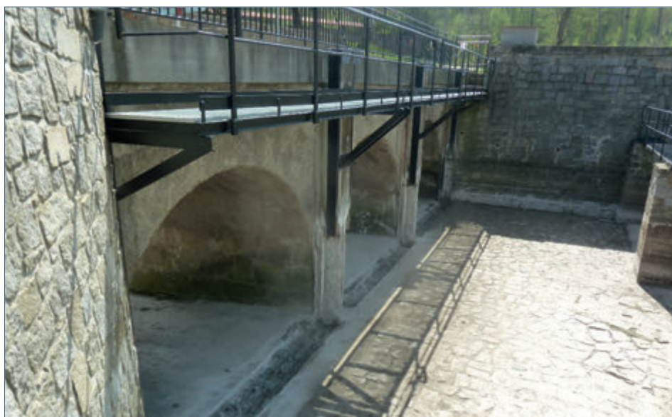
Oprava stavidel (vybourané prahy, vodící profily a demontována stará stavidla včetně pohonů)
