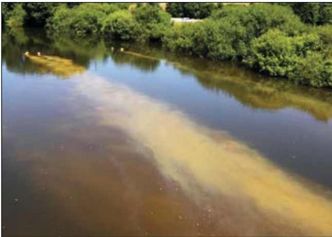
Obr. 6. a 7. Srážení fosforu síranem železitým na přítoku do nádrže – řeka Svatka pod obcí Veverská Bítýška
