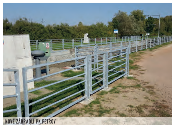
NOVÉ ZÁBRADLÍ PK PETROV
