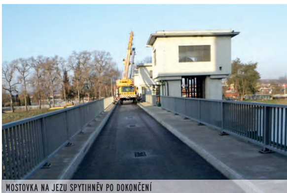
MOSTOVKA NA JEZU SPYTIHNĚV PO DOKONČENÍ
