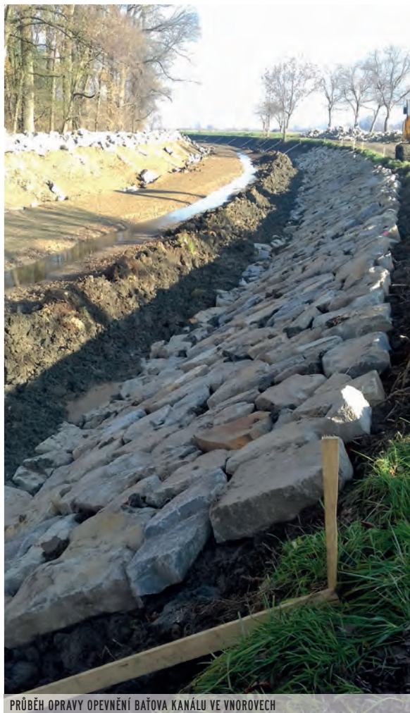
PRŮBĚH OPRAVY OPEVNĚNÍ BAŤOVA KANÁLU VE VNOROVECH
