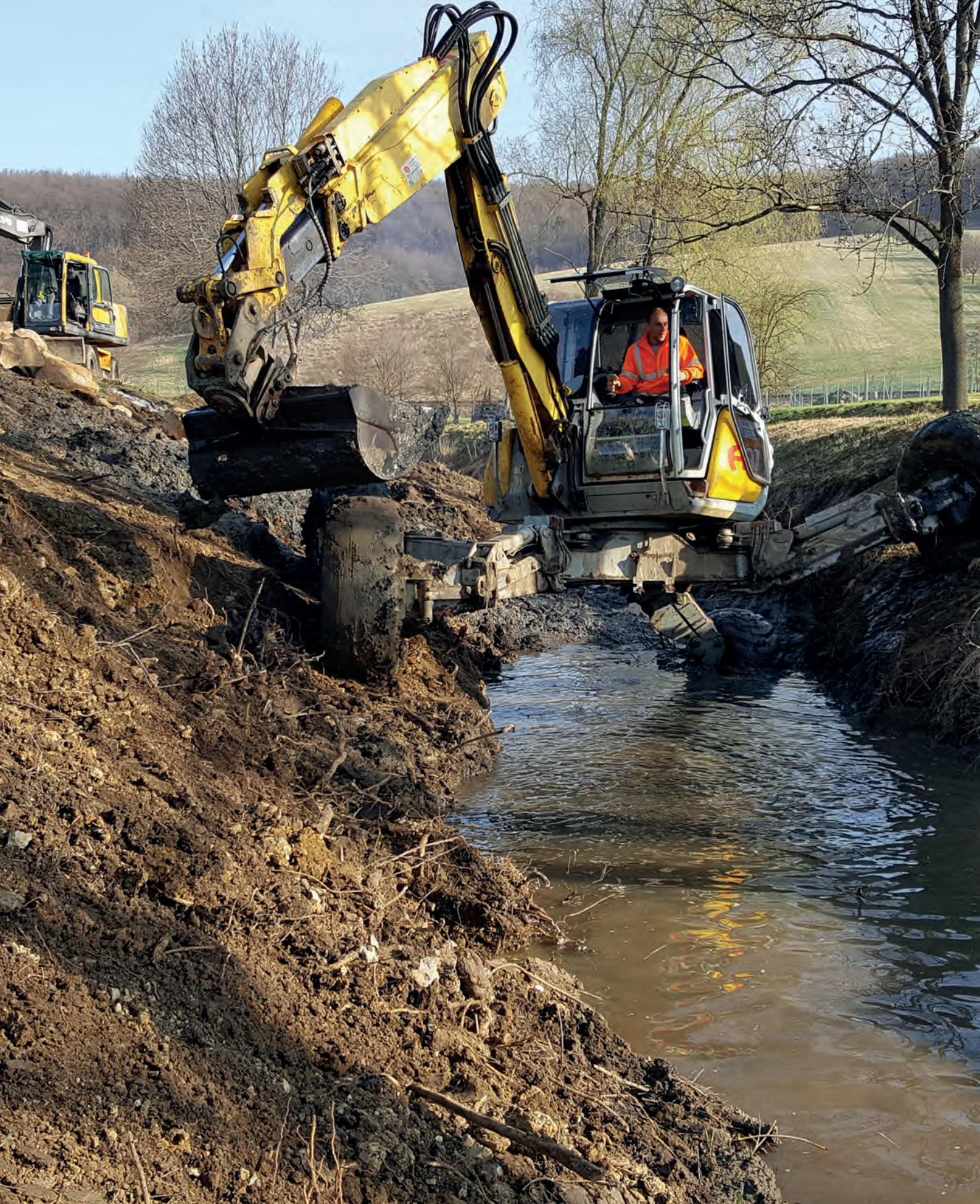
ODSTRANĚNÍ NÁNOSŮ Z KORYTA LEDSKÉHO POTOKA
