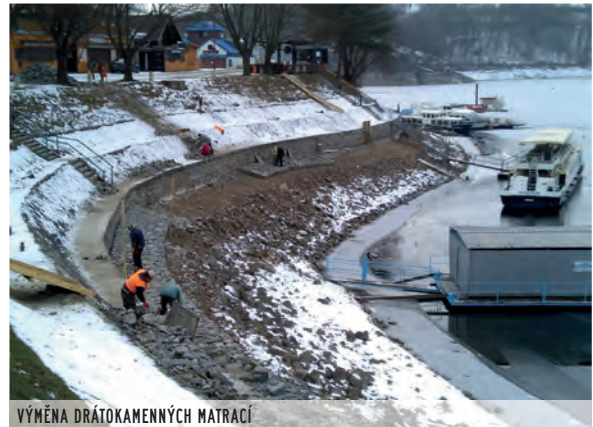
VÝMĚNA DRÁTOKAMENNÝCH MATRACÍ
