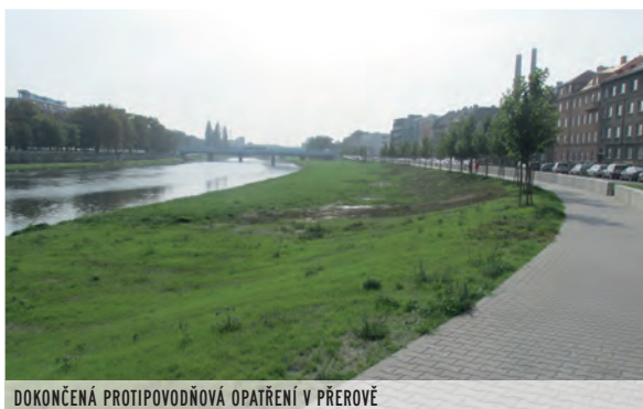
DOKONČENÁ PROTIPOVODŇOVÁ OPATŘENÍ V PŘEROVĚ
