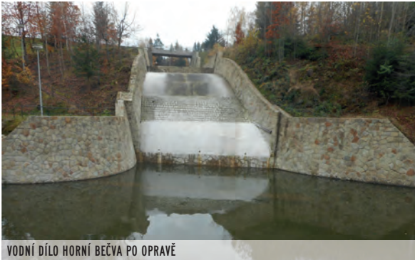
VODNÍ DÍLO HORNÍ BEČVA PO OPRAVĚ
