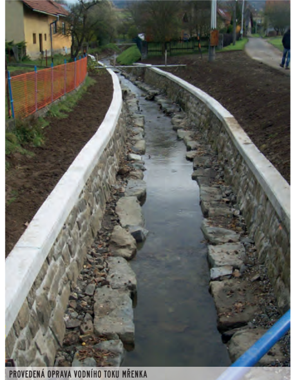
PROVEDENÁ OPRAVA VODNÍHO TOKU MŘENKA
