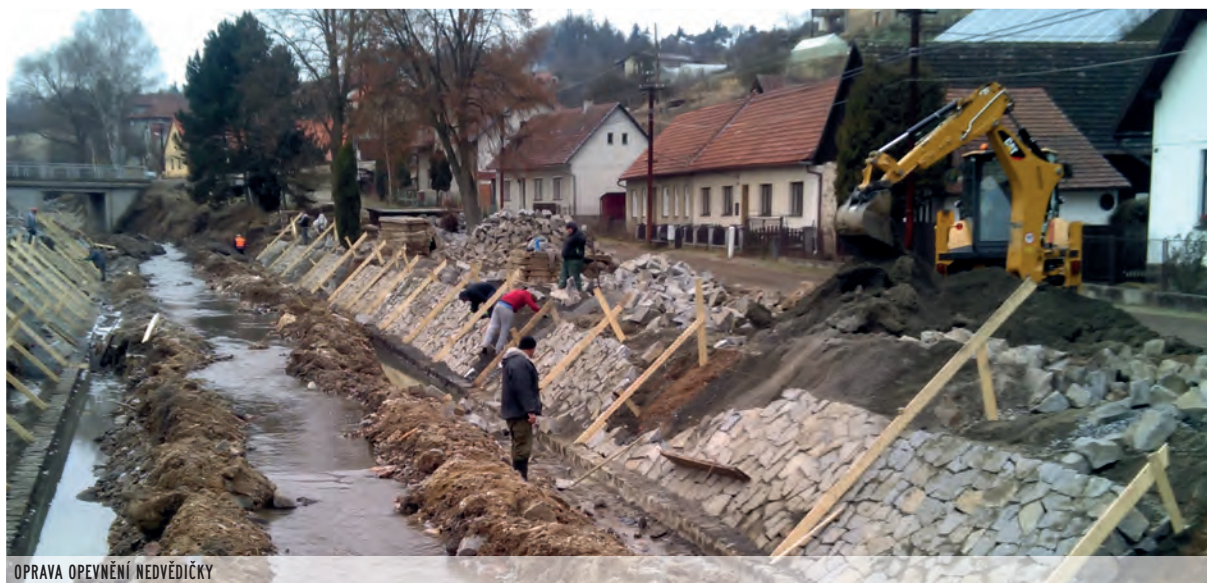
OPRAVA OPEVNĚNÍ NEDVĚDIČKY
