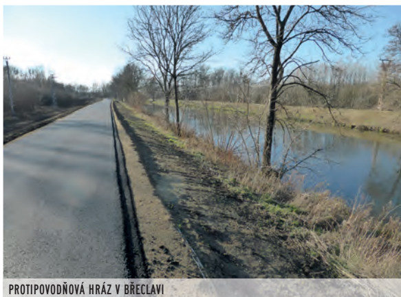
PROTIPOVODŇOVÁ HRÁZ V BŘECLAVI
