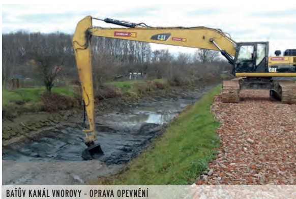
BAŤŮV KANÁL VNOROVY - OPRAVA OPEVNĚNÍ
