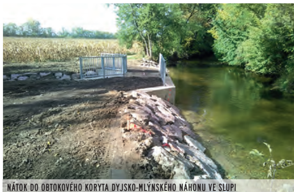
NÁTKO DO OBTOKOVÉHO KORYTA DYJSKO-MLÝNSKÉHO NÁHONU VE SLUPI
