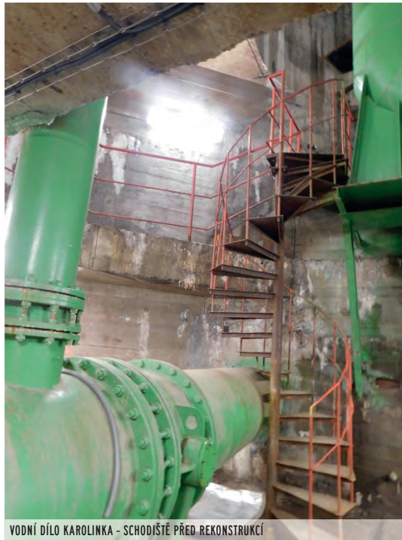
VODNÍ DÍLO KAROLINKA - SCHODIŠTĚ PŘED REKONSTRUKCÍ
