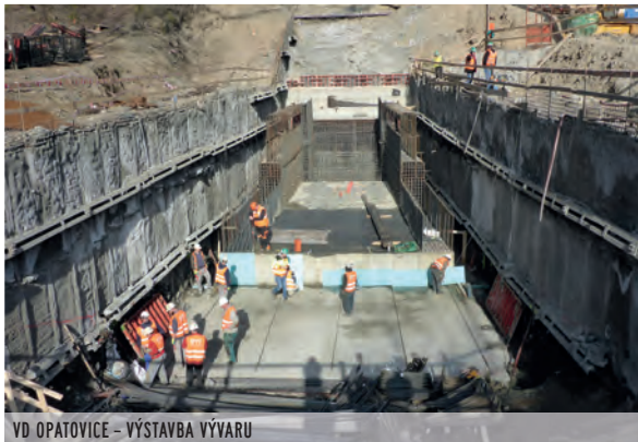
VD OPATOVICE – VÝSTAVBA VÝVARU
