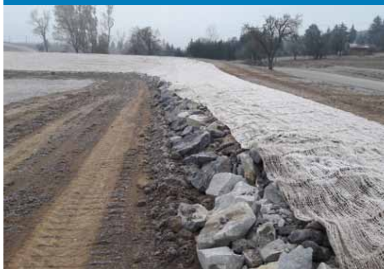
Hráz poldru Okříšky po provedení opravy
