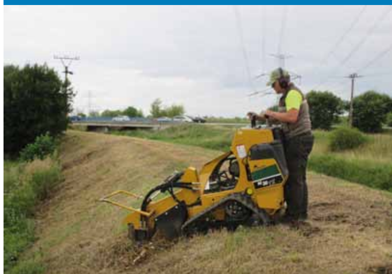
Frézování pařezů na hrázích toku Litava
