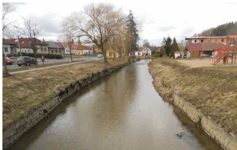
Opravené zdi v Sazomíně ↑ a stav před opravou opěrných zdí ↓
